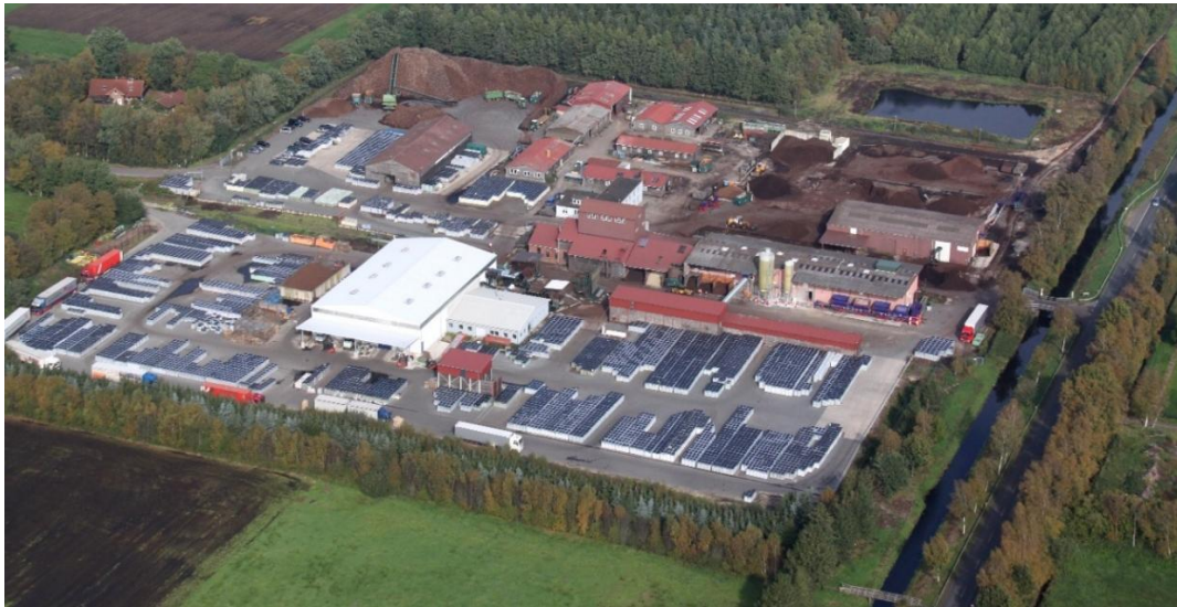
Abbildung 2: Luftaufnahme COMPO Standort in Gnarrenburg
